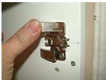
Grundplatten einclippen
